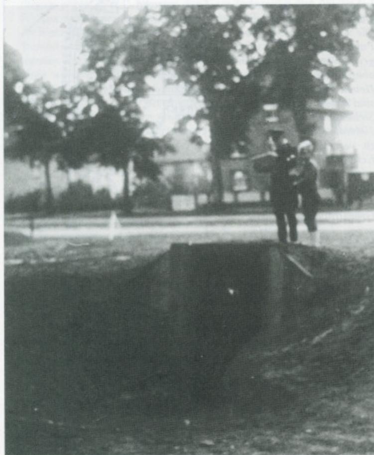
Luftschutzanlagen auf dem Marktplatz in Brackwede (Archiv des Heimatvereins Brackwede)
