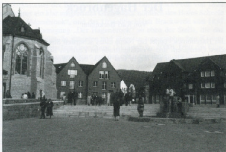
Der neue Kirchplatz (April 1992)
